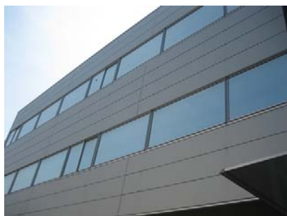
遮光・飛散防止フィルムの貼付
