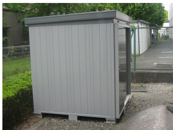
長谷事業所 防災倉庫
